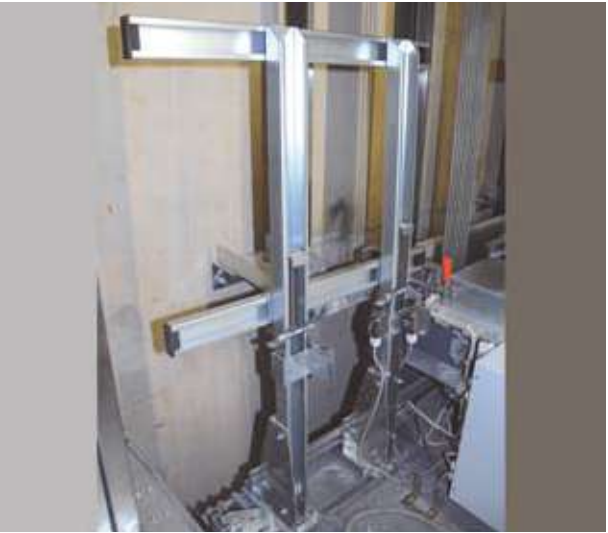
Ejemplo de montaje: guarda cuerpos desplegado
