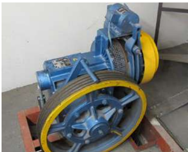
Máquina de Kasper KP120 sin encoder incremental
