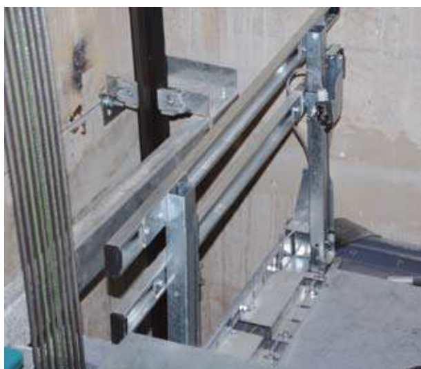
Ejemplo de montaje: guarda cuerpos plegado
