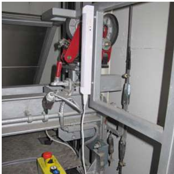
Fijación de la lámpara de emergencia LED en el guarda cuerpos.
