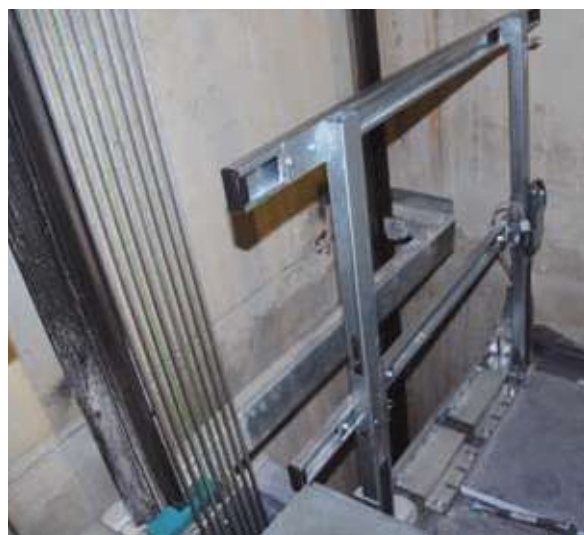
Ejemplo de montaje: guarda cuerpos desplegado
