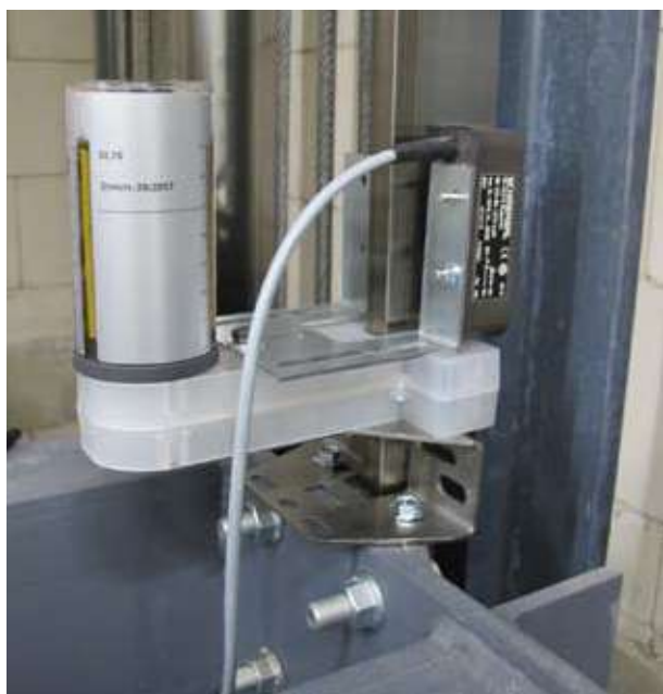
Ejemplo con chapa de montaje para el interruptor magnético
