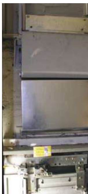
Ejemplo de montaje revestimiento mural para el hueco
