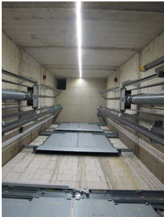
Ejemplo de montaje: Montacargas, capacidad de carga 1,6 t con una base del hueco de 6,4m 2
