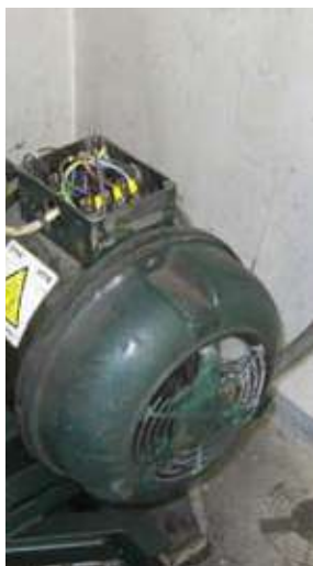
Máquina de OTIS 10AT sin y con encoder
