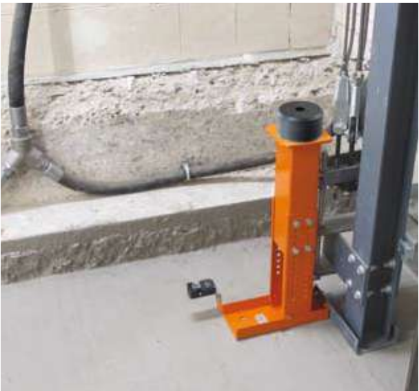
Ejemplos de fijación del soporte de mantenimiento en el soporte del pistón
