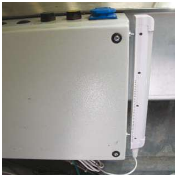
Fijación de la lámpara de emergencia LED en la caja de control.
