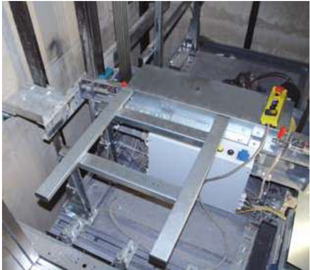
Ejemplo de montaje: guarda cuerpos plegado
