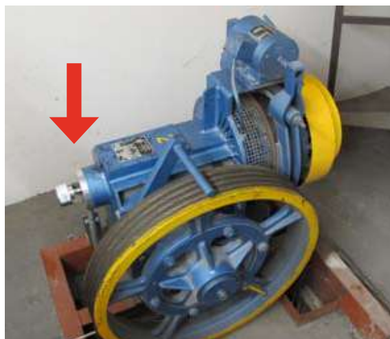
Máquina de Kasper KP120 con encoder incremental
