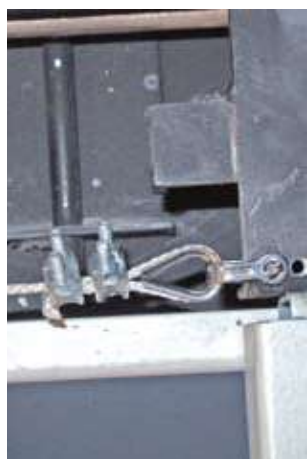
C Fijación de la cuerda en el carro de la puerta
